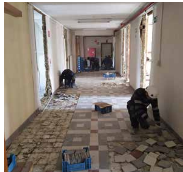
»Odstranjevanje ploščic pri rušenju«. Vir: Rotordc www.rotordc.com
